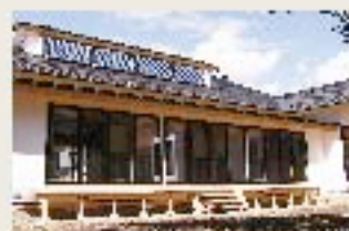
中庭2(太陽熱利用システム)
