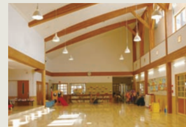
遊戯室(大断面構造集成材45分準耐火構造)
