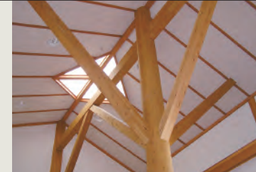
玄関ホール天井
