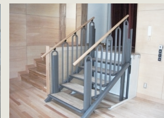
車椅子の生徒もステージに上がることができる車椅子対応段差解消機
