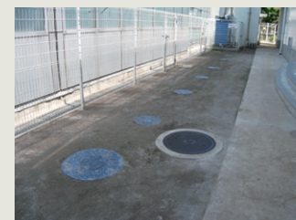
三鷹市の公共施設として初のマンホール トイレに対応する排水設備
